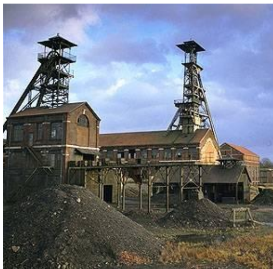
Vestiges de la fosse d'Arenberg, avant restauration, à Wailers (Nord)
